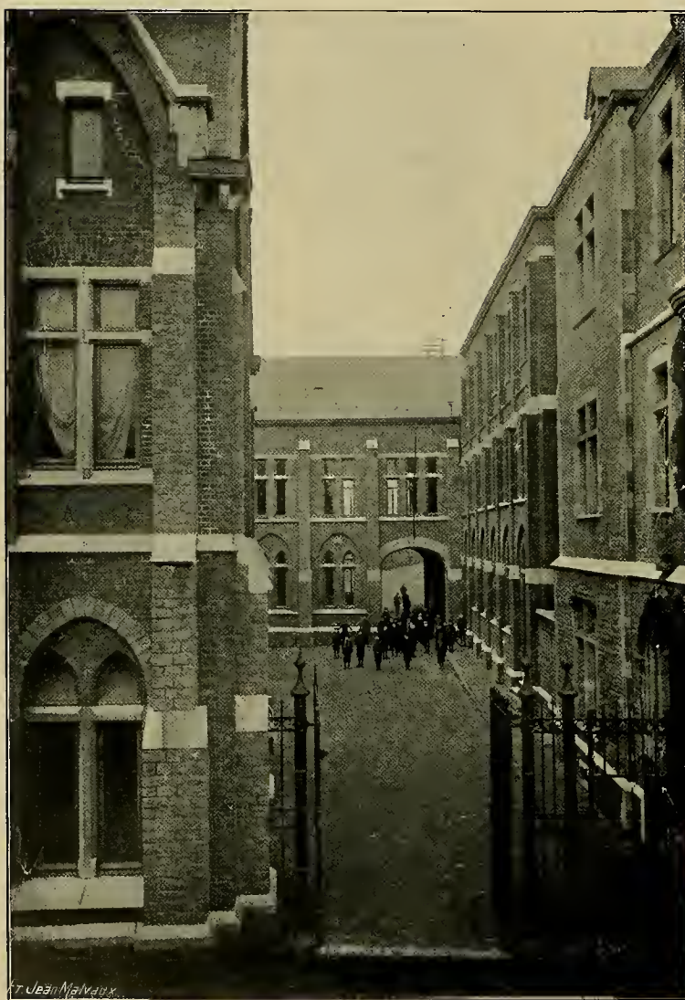
Les Œuvres sociales de Morlanwelz : La Maison des Ouvriers.
